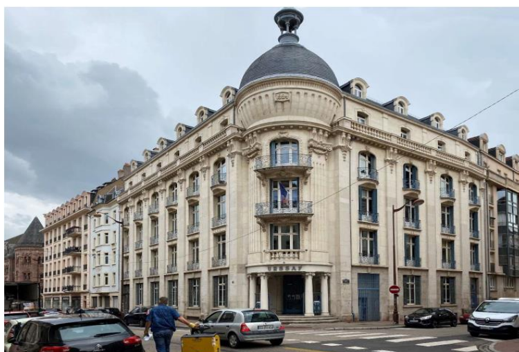
Reconversion du siège lorrain de l'URSSAF - 4-6 rue Pasteur à Metz
