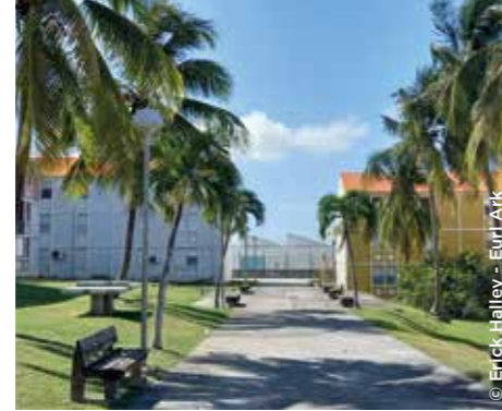
La résidence Les Barbades bénéficie de travaux de réhabilitation et de confortement parasismique (SIG).
