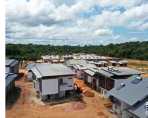
Construction de 16 logements locatifs sociaux dans la ZAC de Concorde Nord, à Matoury (SEMSAMAR).
