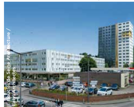
Rénovation du Parc de Robec, à Darnétal (Logeo Seine).
