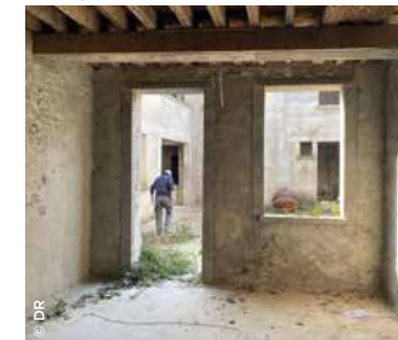
Démarrage de la réhabilitation d'anciennes Boucanes* à Fécamp.
