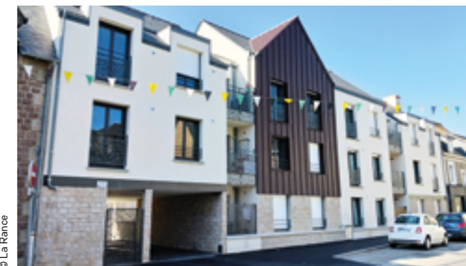
À Saint-Malo (35), livraison par La Rance de la résidence Les Six Frères Ruellan.
