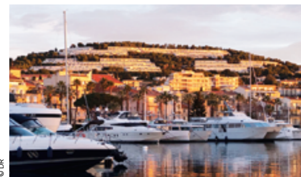
Ancienne résidence de vacances réhabilitée située à Bandol (83), le Panorama propose 86 logements dont 25 réservés à de jeunes actifs de moins de 30 ans, notamment des saisonniers (Unicil).
