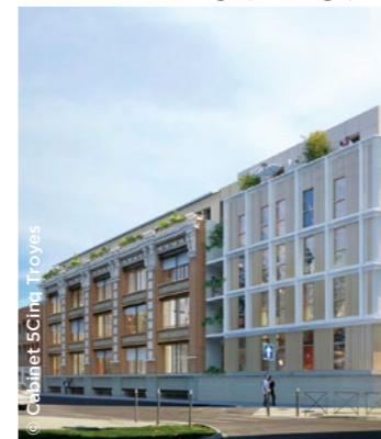
À Troyes (10), réhabilitation et transformation d'usage (Mon Logis).
