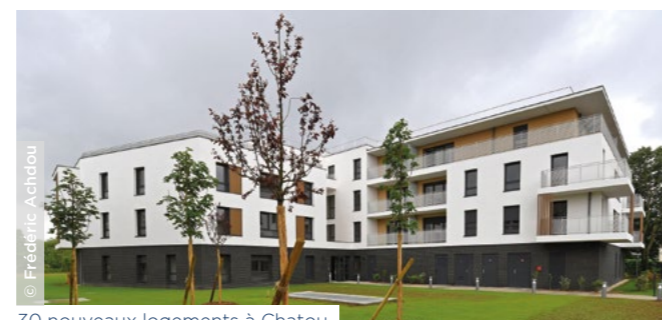
30 nouveaux logements à Chatou.
