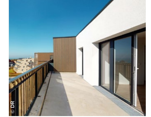
À Sainte-Adresse (76), métamorphose de la résidence Lopofa réhabilitée ( Logeo Seine ).
