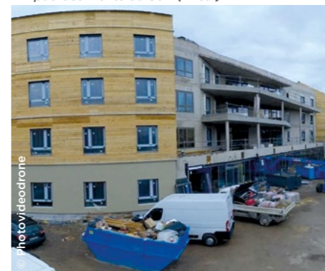
À Montbrison (42), reconstruction en cours de l'Ehpad des Monts du Soir ( Énéal ).
