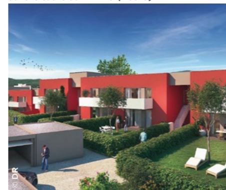
À Belfort (90), la future résidence Le Bartholdi, dans le cadre du NPNRU ( Néolia ).
