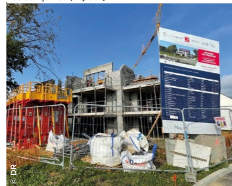
Au Tour-du-Parc (56), construction de la résidence Les Jonquilles (Espacil).
