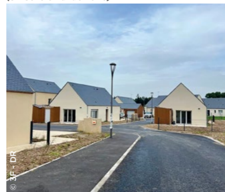
À Montbazac (37), la résidence Villa Balzac 2 (3F Centre Val de Loire).
