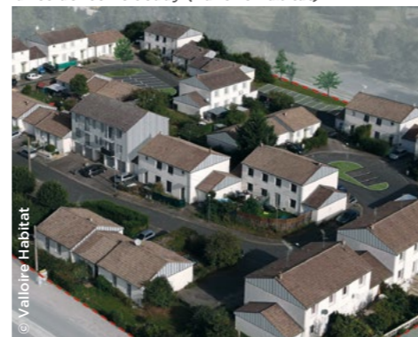
À Sully-sur-Loire (45), réhabilitation en cours pour la résidence Le Jeudy (Valloire Habitat).
