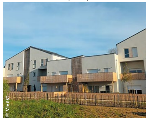
À Blénod-lès-Pont-à-Mousson (54), 24 logements en locatif intermédiaire ( Vivest ).
