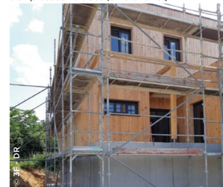
À Bouxières-aux-Dames (54), construction à partir d'un procédé hors site ( 3F Grand Est ).
