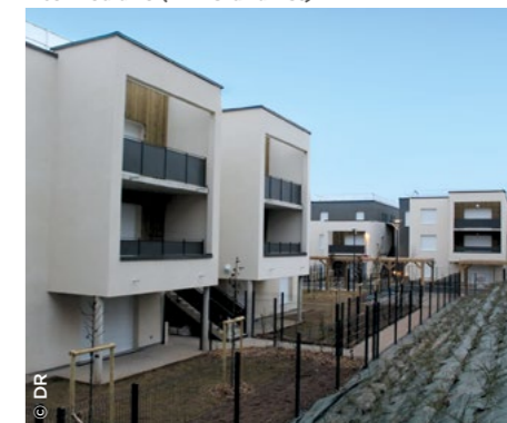
À Thionville (57), 36 logements en locatif intermédiaire ( In'li Grand Est ).
