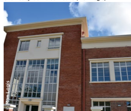
À Troyes (10), réhabilitation avenue Chomedey-de-Maisonneuve ( Mon Logis ).
