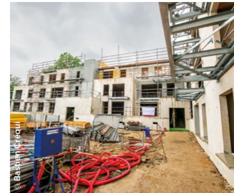
À Gravelines (59), construction de logements en locatif social et intermédiaire (Flandre Opale Habitat).
