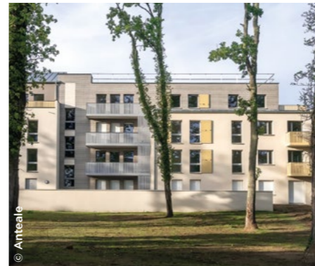
À Compiègne (60), la résidence de l'Avenue de la Faisanderie (Clésence).
