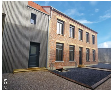
À Saint-Omer (62), réhabilitation de 9 logements dans le cadre d'Action Cœur de Ville.
