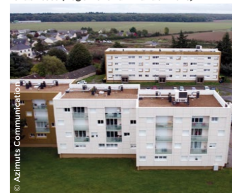
Les résidences Porte des Champs et Les Parfondines réhabilitées (Logement Familial de l'Eure).
