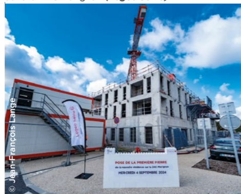
À Elbeuf (76), construction de 50 logements sociaux dans la ZAC Marignan (Logeo Seine).
