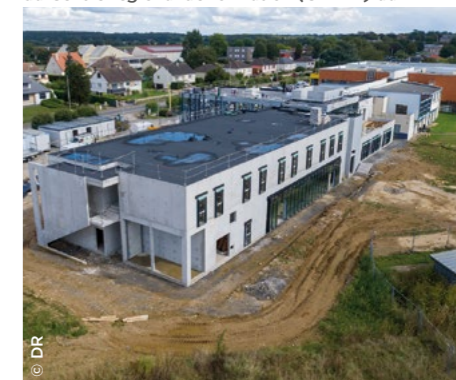
Au Grand Bourgtheroulde (27), extension des locaux du Centre régional de formation (CEREF) du BTP.
