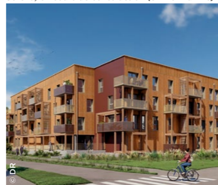
À Val-de-Reuil (27), la future résidence Villa Séréna, en cours de construction (3F Normandie).
