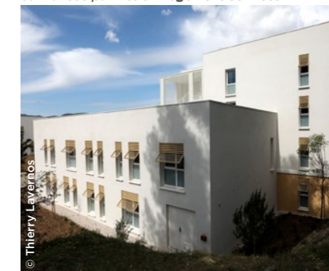
À La Ciotat (13), la résidence sociale Le Peymian, cofinancée par Action Logement Services .
