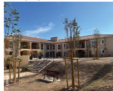
À Eyragues (13), la première tranche de la résidence Les Craux ( Unicil ).
