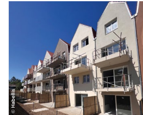
À Dijon (21), la résidence Argentières pendant sa construction ( Habellis ).
