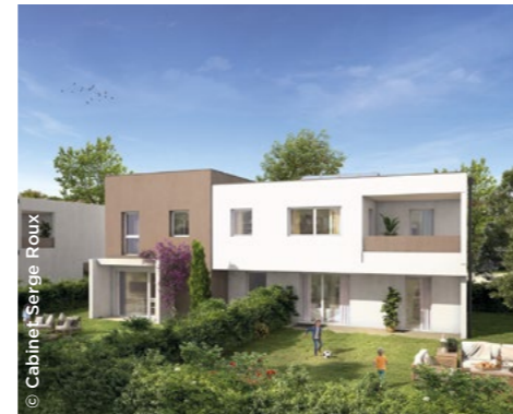
À Tavaux (39), la construction du lotissement de la Vuillardière a démarré en mars ( Néolia ).
