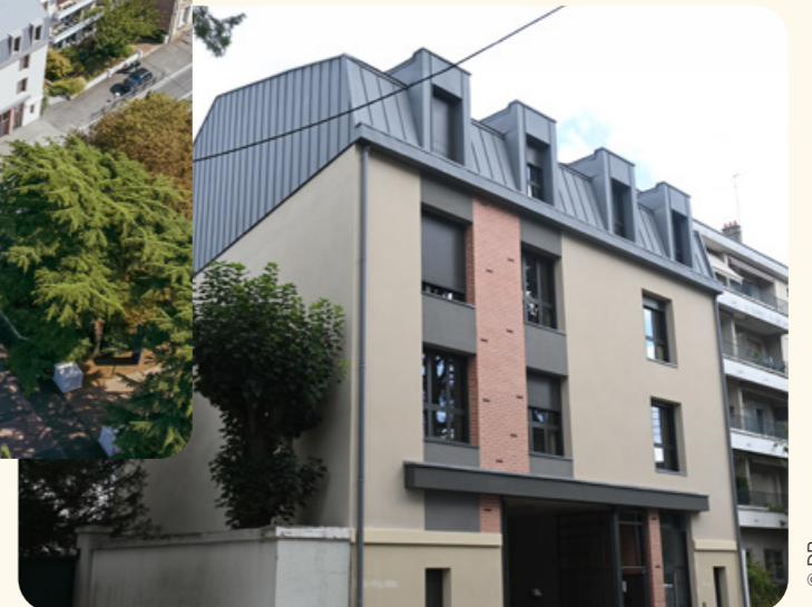
La 14 e résidence pour étudiants proposée par Podeliha a été inaugurée fin août 2025 au cœur d'Angers (49). 68 logements répartis sur 2 bâtiments (61 T1 et 7 T3 réservés à la colocation) - Gestion : Podeliha.
