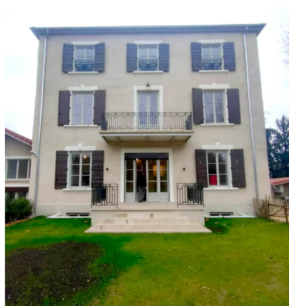
À Albigny-sur-Saône (69), la maison des frères Voisin (pionniers français de l'aviation) entièrement restaurée grâce à l'intervention de Digneo , abrite désormais 6 logements livrés fin 2024.
