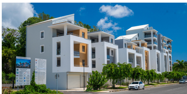
En Guadeloupe, à Pointe-à-Pitre, la résidence Les Voiles du Mémorial (Sikoa).
