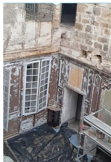
Projet en chantier © SCI 10 rue de Clermont
