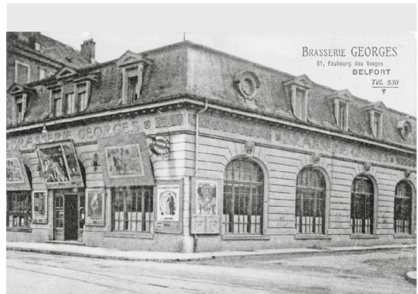
La brasserie était à sa construction surmontée d'une frise à double corniche et d'une mansarde Photographie depuis l'angle de la rue d'Alger en 1950
