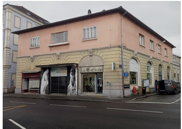
Le bâtiment se perçoit avec son angle qui laisse voir le retournement de la façade Photographie depuis l'angle de la rue d'Alger aujourd'hui
