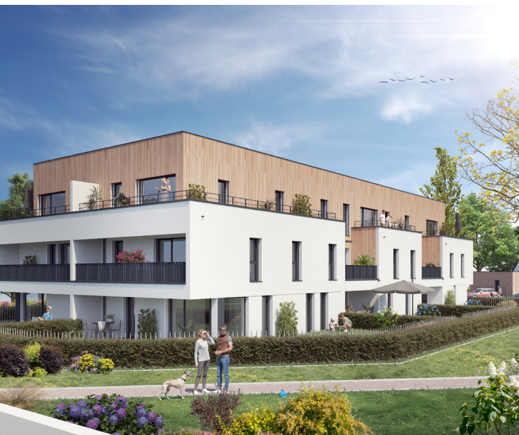
© Ada architecte / Coopalis
