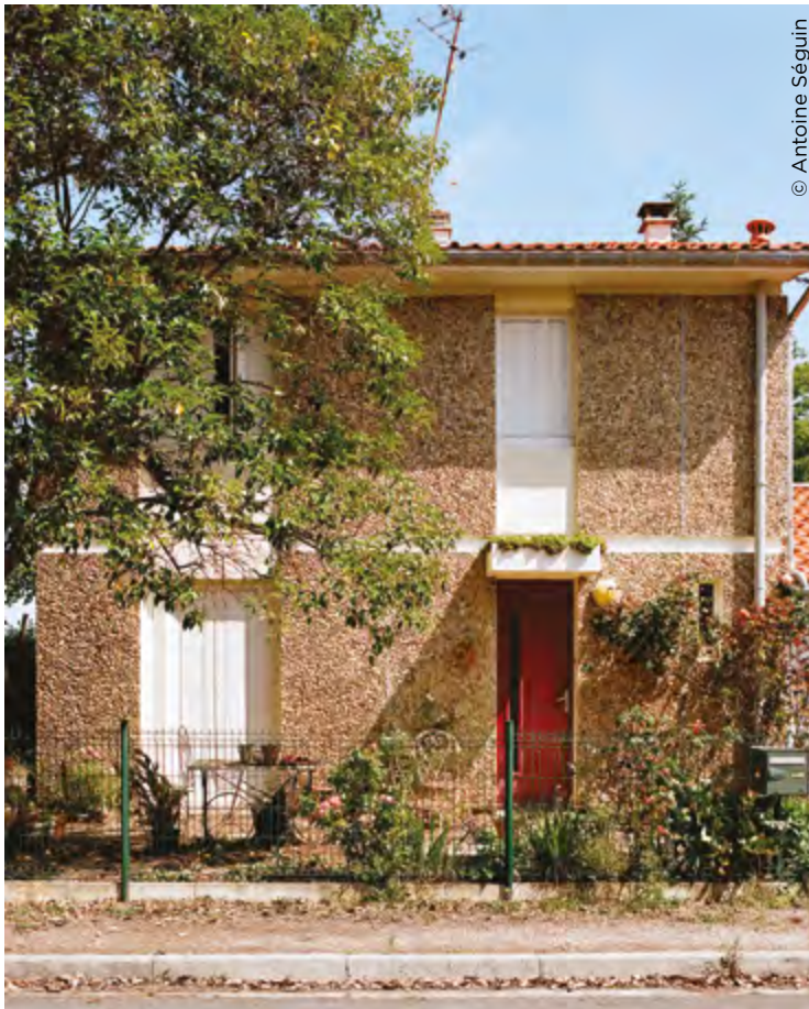
Village Hénault, rue des Coquelicots à Villerouge (33) 12 pavillons de Clairsienne construits en 1972 pour loger les ouvriers viticoles du Libournais, caractérisés par leurs façades en cailloux lavés.
