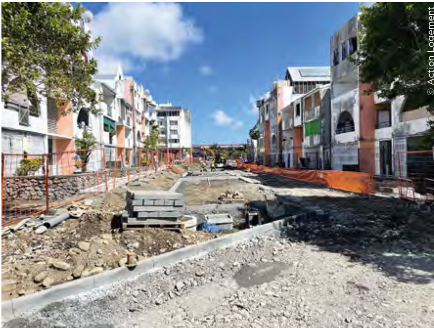
À La Réunion, à Saint-André (97440), travaux de renouvellement urbain menés par la SHLMR pour les 216 logements de la résidence Victoria.
