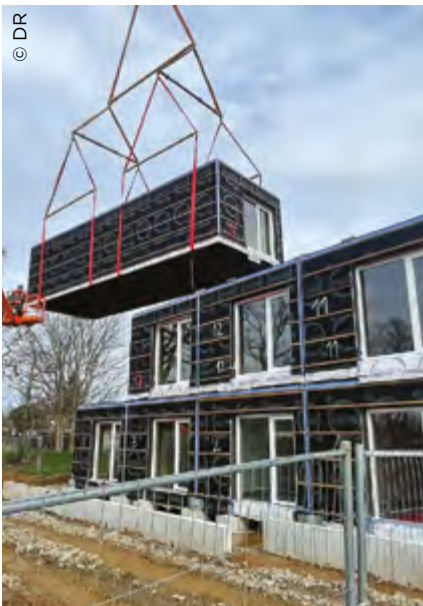
© DR Espacil Habitat finalisera, en août 2024, la livraison à Redon (35) de 24 logements modulaires en bois 3D destinés à des moins de 30 ans, prioritairement actifs et apprentis, bénéficiant d'un bail d'un an renouvelable.
