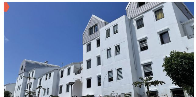
Façade réhabilitée de la résidence Victoria – Saint-André © Action Logement
