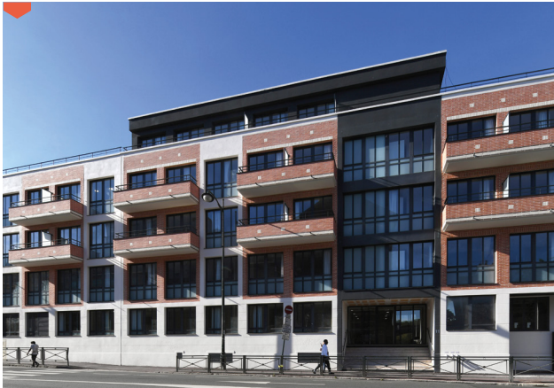
Exemple d'intervention de la FTI à Corbeil-Essonnes, en accompagnement de Seqens dans la transformation d'un immeuble de bureaux en logements étudiants et familiaux © Frédéric Achdou
