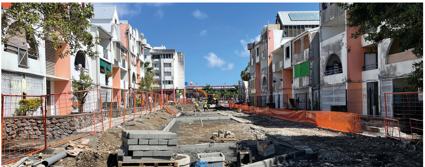
Chantier de résidentialisation de la résidence Victoria – Saint-André © Action Logement
