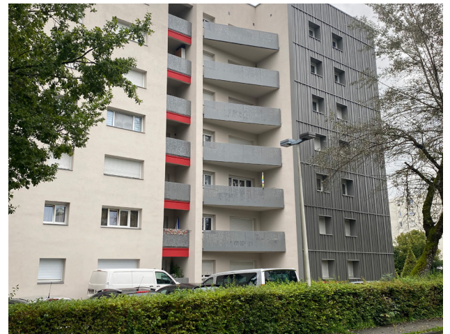
Montbéliard (25) · Quartier de la Petite Hollande · Réhabilitations BBC de 330 Logements par Neolia · L'un des bâtiments rénovés rue Brossolette
