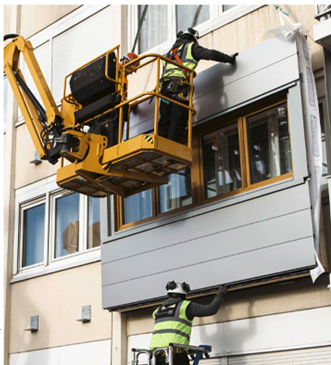
À Thiais (94), réhabilitation hors-site, avec la pose de panneaux de façade réalisés sur mesure en usine (Immobilier 3F).
