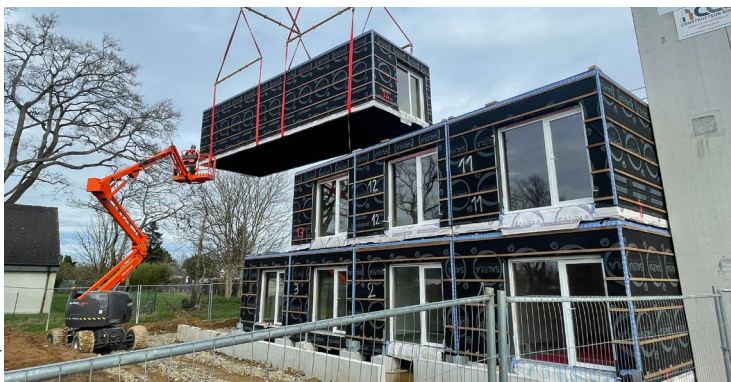
À Redon (35), assemblage de l'un des 24 logements modulaires (Espacil).
