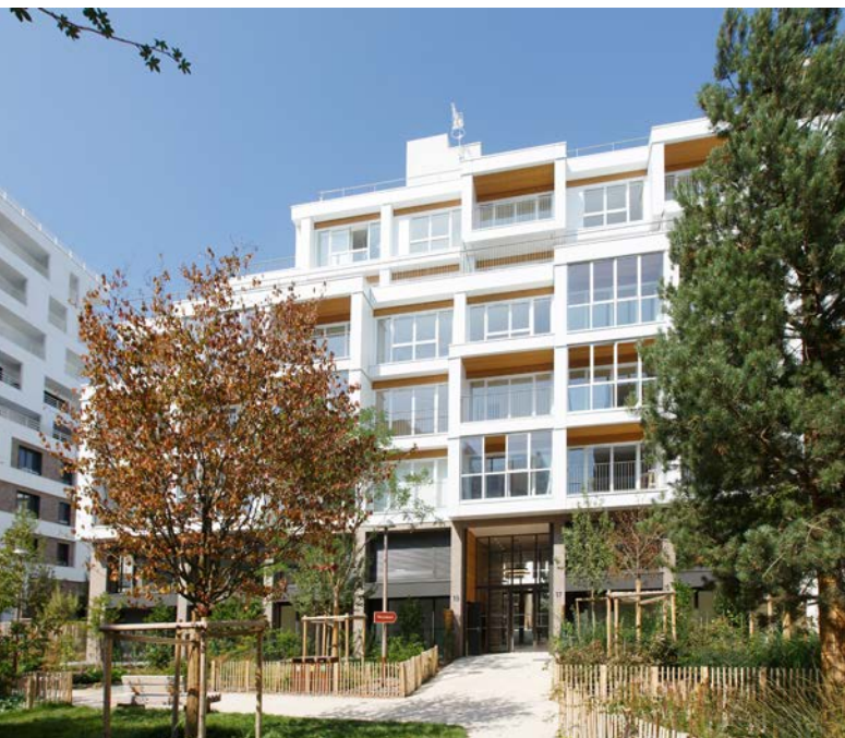
À Rueil-Malmaison (92), in'li livrait en octobre Petraea, une nouvelle résidence Woodeum de 26 logements intermédiaires en bois massif CLT* à faible empreinte carbone.
