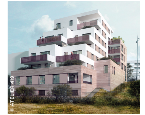
À Chambéry (73), le bâtiment surélevé de la résidence Les Terrasses du Nivolet ( Foncière Logement ).
