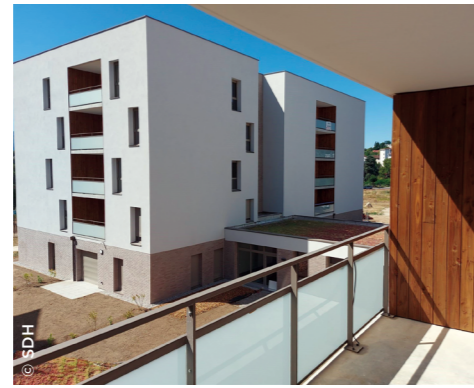
À Saint-Martin-d'Hères (38), la nouvelle résidence étudiante Joséphine Baker ( la SDH ).
