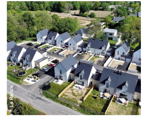
À Quévert, le domaine de Margot 1 et 2, un ensemble de 36 logements dont 32 maisons ( La Rance ).
