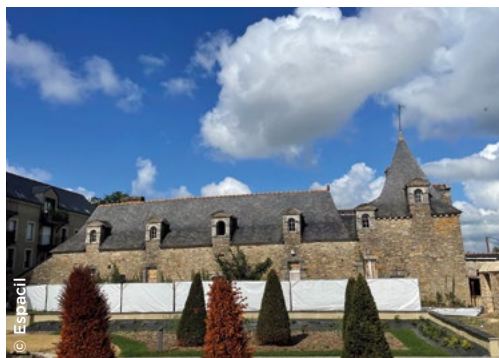
Sur le site classé du château de la Baratière, réhabilitation de 3 bâtiments anciens (Espacil).
