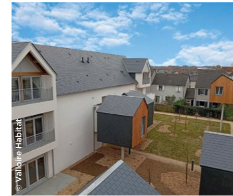
À Saint-Pierre-des-Corps (37), la résidence Canopée, en locatif intermédiaire ( Valloire Habitat ).
