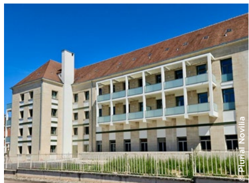
Un ancien site d'Orange transformé en résidence de 20 logements ( Plurial Novilia ).
