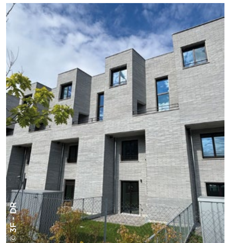
À Lille, nouveaux logements équipés d'un chauffe-eau thermodynamique ( 3F Notre Logis ).
