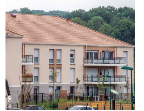
À Sérifontaine (60), 41 logements dont 16 pour seniors et 10 pour personnes en situation de handicap ( Clésence ).
