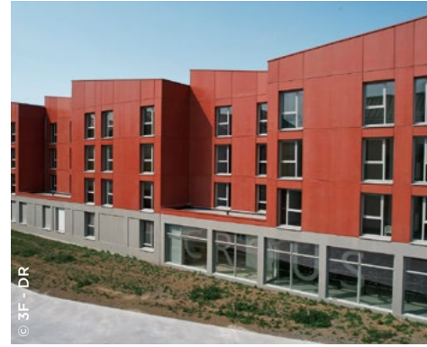
À Dunkerque (59), nouvelle résidence universitaire de 70 logements ( 3F Résidences ).
