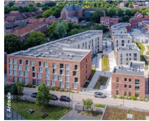
À Roubaix (59), résidence étudiante, résidence Jeunes et logements en colocation ( Clésence ).
