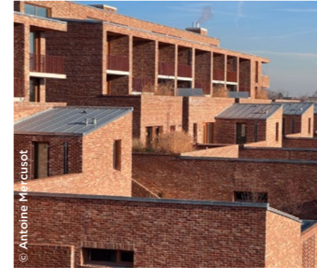
À Arpajon (91), ensemble de 56 logements, salles associatives et commerces (Immobilier 3F).
