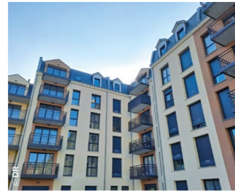
À Dieppe (76), au sein de la résidence Îlot Porte, 39 studios réservés aux moins de 30 ans ( Logeo Seine ).
