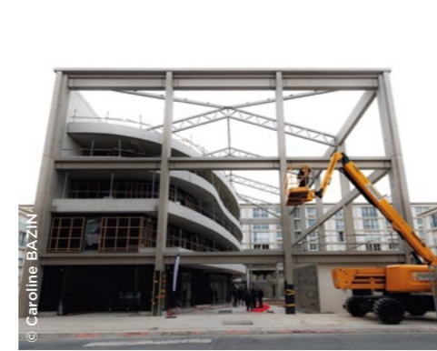
Au Havre (76), construction en cours du Passage des Cinémas ( Logeo Seine ).
