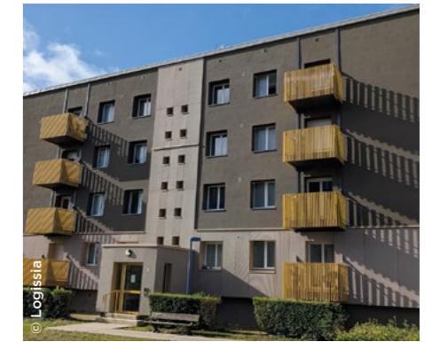
À Flers (61), les 112 logements réhabilités de l'allée des Pierres-Précieuses ( Logissia ).
