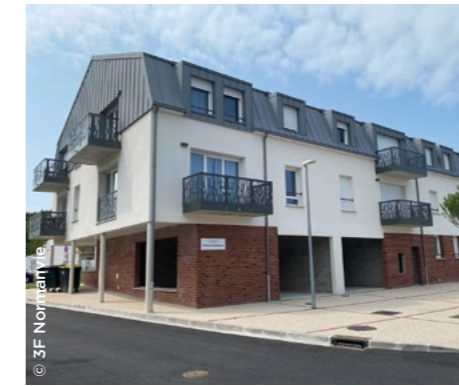
À Petit-Caux (76), la nouvelle résidence Les Hortensias ( 3F Normandie ).
