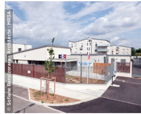
À Cugnaux et Villeneuve-Tolosane (31), caserne de gendarmerie et ses logements de fonction ( Promologis ).
