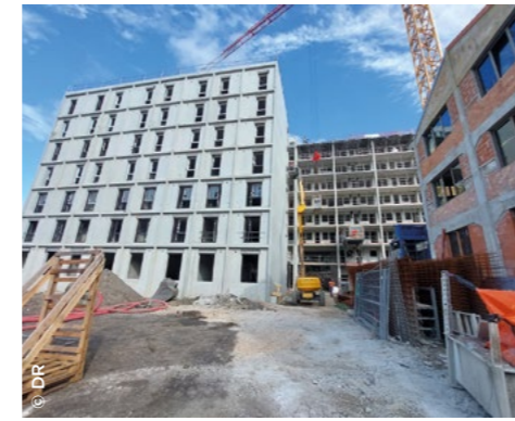
À Marseille (13), construction de la résidence étudiante La Plateforme ( Unicil ).
