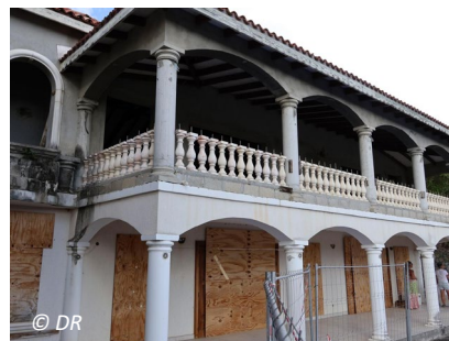
À Saint-Martin, à Friar's Bay, transformation de la résidence Isabella (Sikoa).
