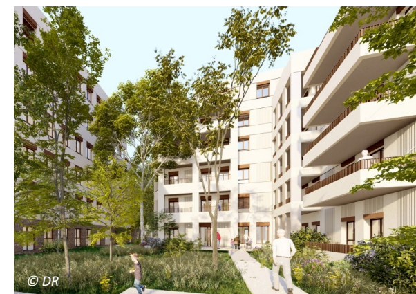
À Villeurbanne (69), la résidence EKÖ , réalisée par Arcade-VYV, est issue de la reconversion d'un ancien site de la MGEN en un bâtiment résidentiel à destination des seniors et de leurs aidants, une maison médicale et des bureaux.
