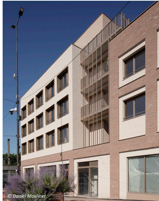
Au Vésinet (78), Seqens Solidarités a livré en août 2025 une nouvelle résidence universitaire de 98 logements.
