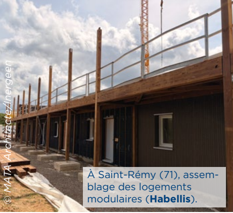
Au Creusot (71), construction de logements à ossature bois/paille (Habellis).
