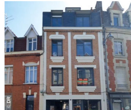
À Arras (02), réhabilitation réalisée dans le cadre d'Action Cœur de Ville.
