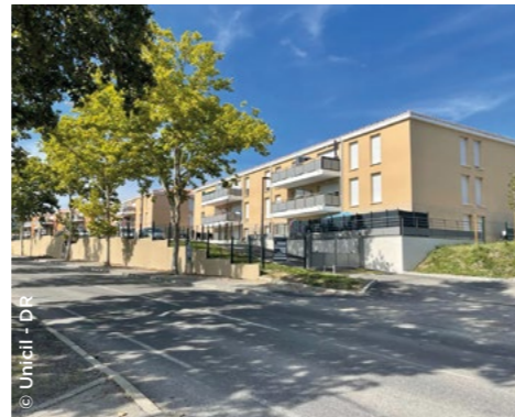
73 nouveaux logements à Manosque, avenue du Luberon - Unicil.
