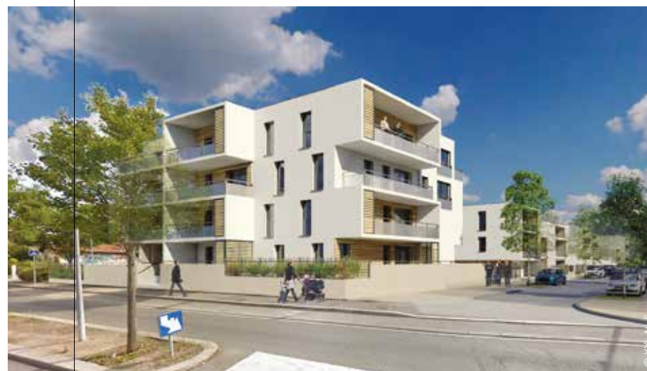
La résidence Caravelle propose des logements locatifs intermédiaires à Bron, dans la Métropole de Lyon (69) – in'li Aura.
