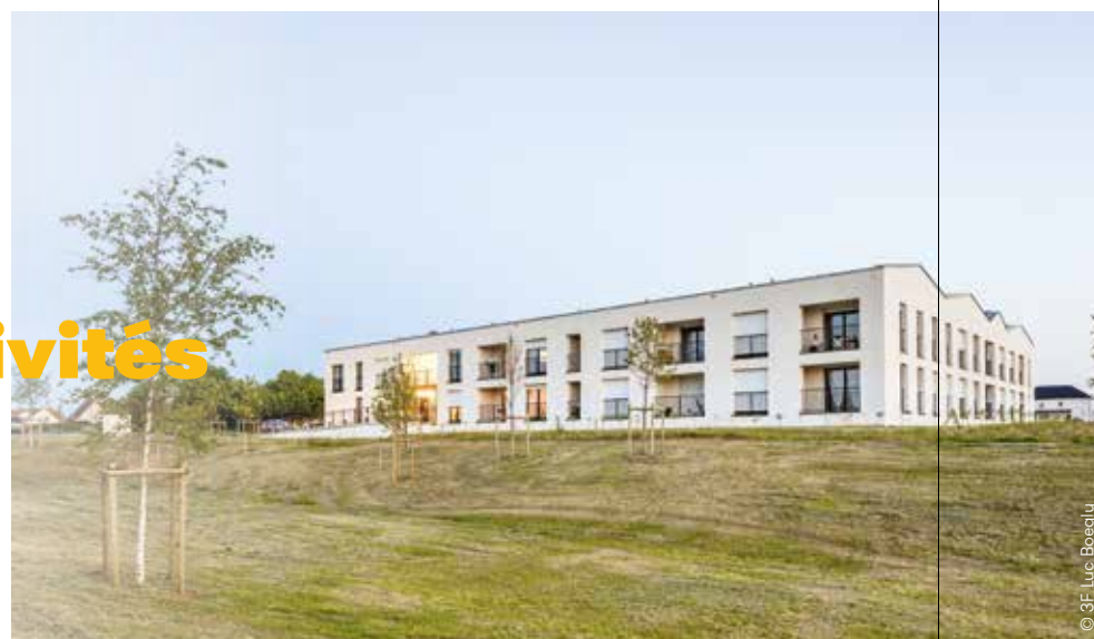
Située à Bretteville-sur-Odon (14), la résidence Le Patio est labellisée Bâtiment à Énergie Positive (Bepos) et a été conçue selon le process BIM – Immobilière Basse Seine.
